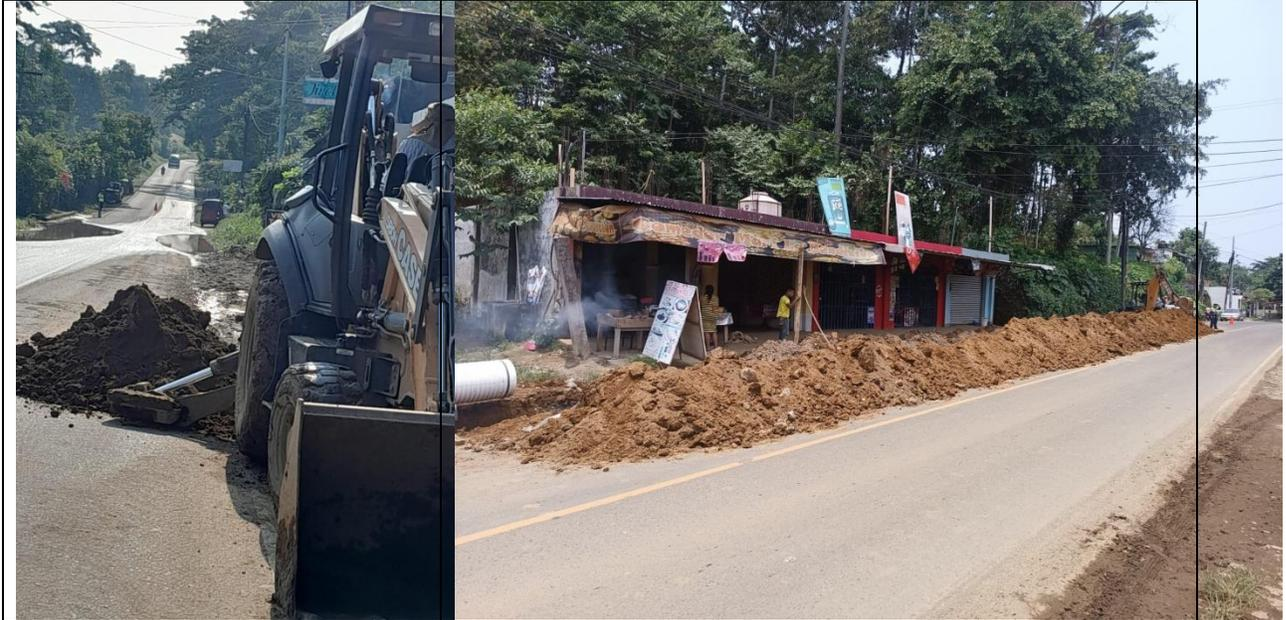
En la ruta RDQUE03 en el kilómetro 216 jurisdicción de Caserío Tres Cruces se procedió a brindar apoyo en regulación vehicular y peatonal por trabajos de maquinaria pesada para colocar tubería de aguas pluviales.
